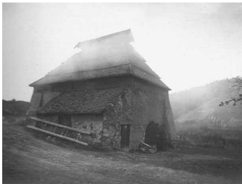
Obrázek 30: Cihelna od zbytkového statku ve Všetatech
