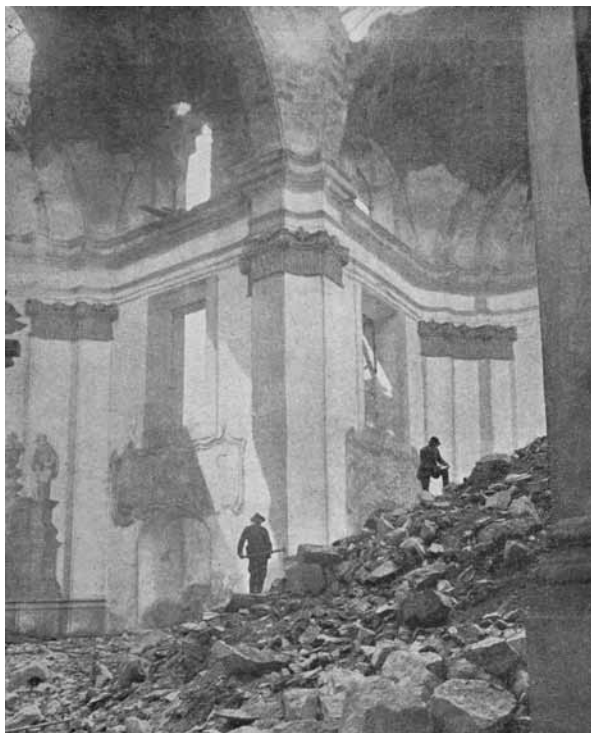
Obrázek 37: Mariánská Týnice – pohled na rmutišťe v kostele po zřícení kopule
